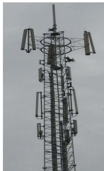
Het "digitale" asbest van Nu
